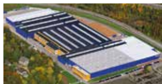
Hörmann KG Eckelhausen, Allemagne
